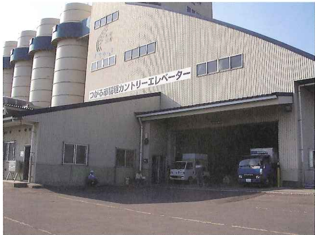
カントリーエレベーター
